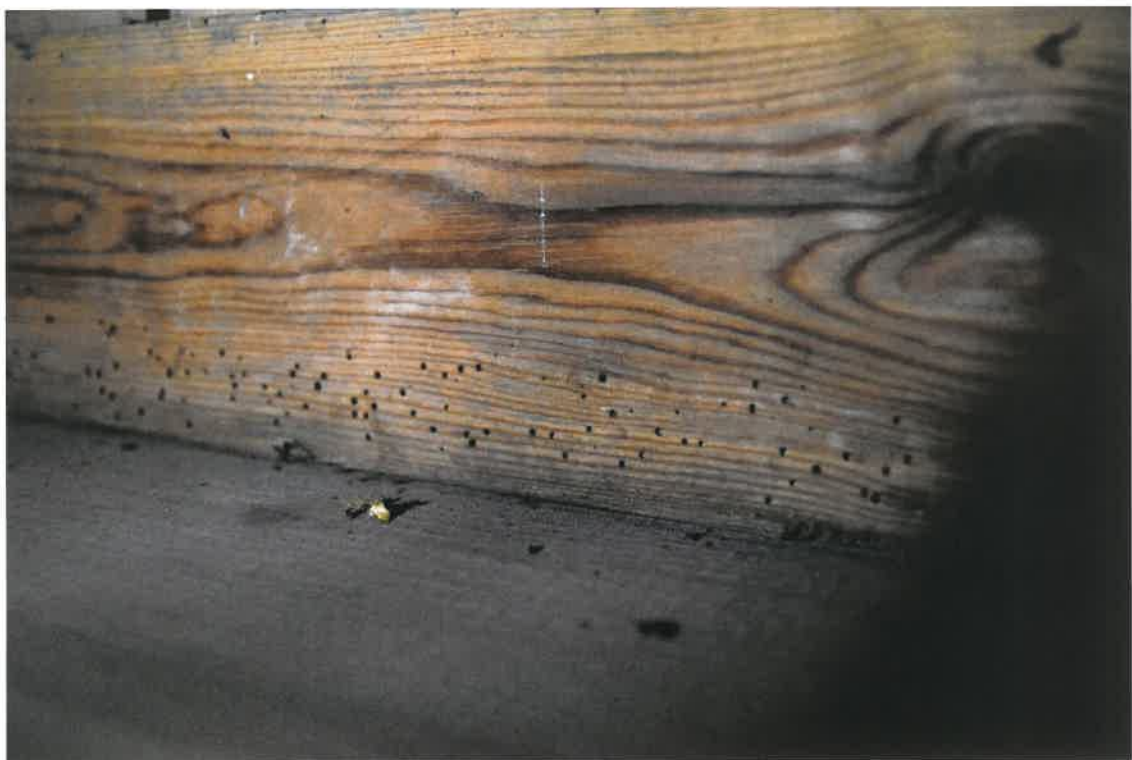
Fotografia nr 17 – Otwory wylotowe we wnętrzu szafy organowej (autor – Filip Presseisen, 2024 r.)
