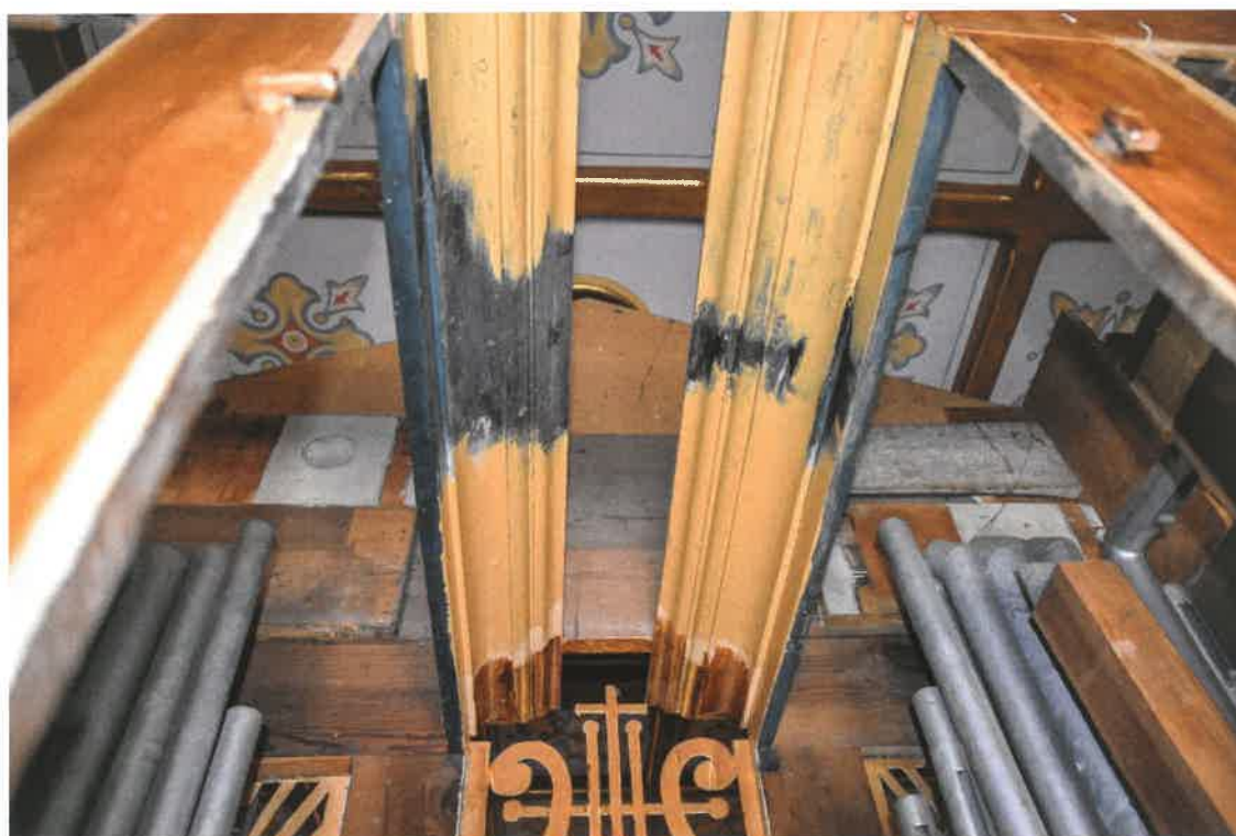
Fotografia nr 6 – Środek szafy organowej, widoczne przemalowania (autor – MPP, 2024 r.)
